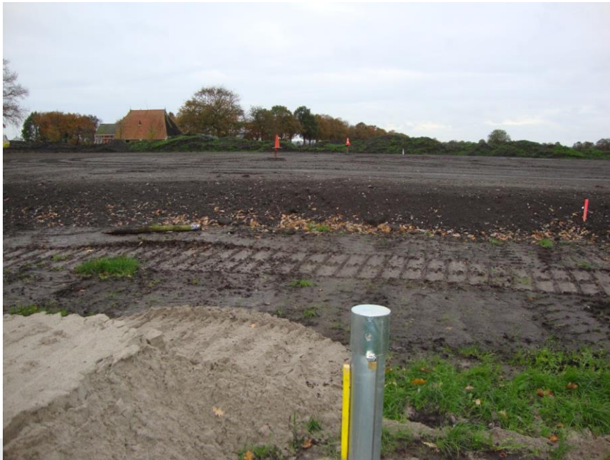
Foto: Bij 20: Monitoringsvoorziening: aanbrengen peilbuis.
