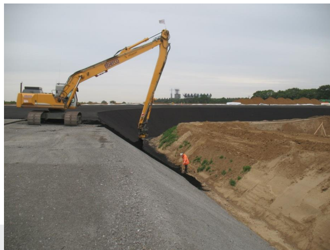
Foto: Aanleg van zandbentonietpolymeergel.
