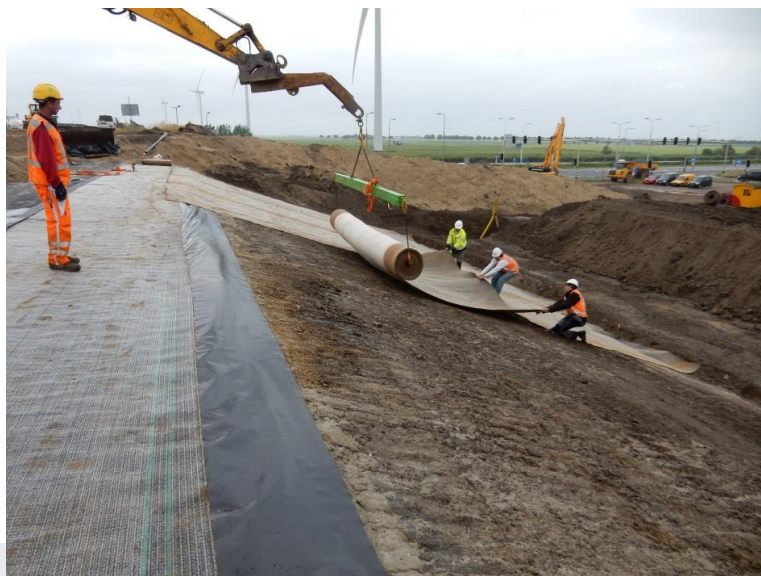
Foto: Toepassing bentonietmat.
